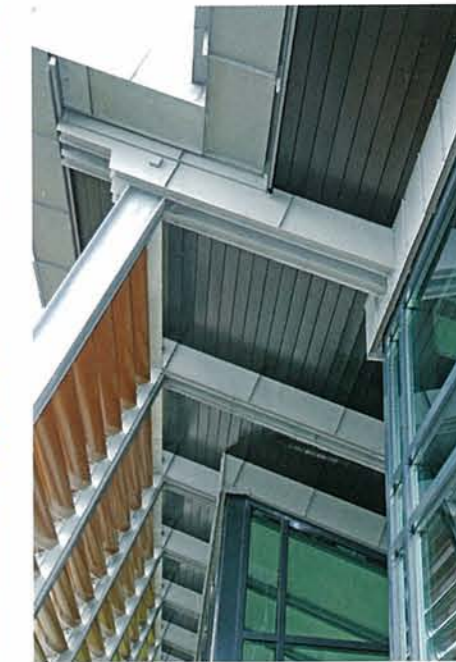
To limtredragere er parvis boltet fast på skråstilte stålstendere i forkant av hytta.
