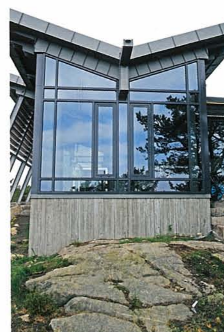
Takvinkelen krevde noen utfordrende løsninger for å hindre vanninntrengning.
